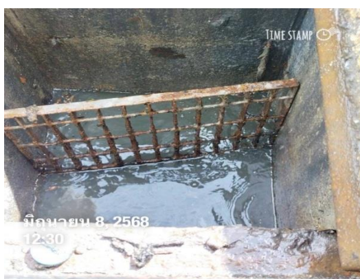
ภาพที่ 12 ตะแกรงดักขยะที่ Man Hole สุดท้าย
